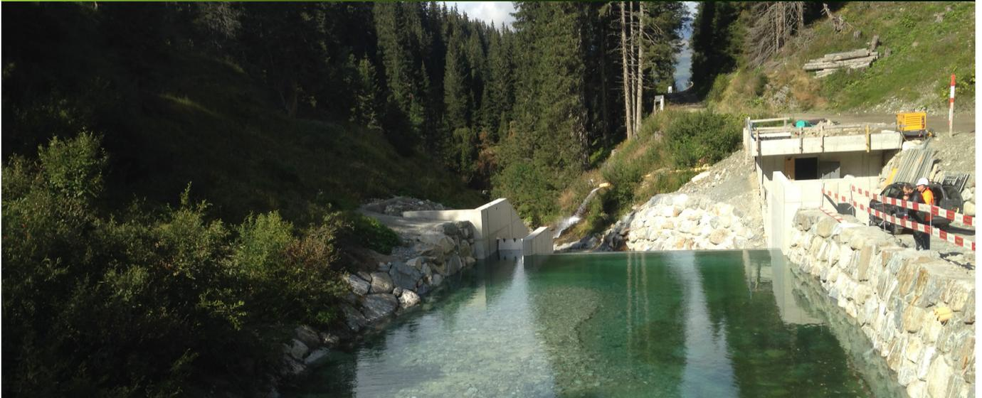
Die Optimierung vom Kraftwerk «Tschar» umfasste die Erneuerung des seit 1946 in Betrieb stehenden Kraftwerks Tavanasa-Obersaxen. Das bestehende Werk wurde saniert und die Ausbauwassermenge mit einer zusätzlichen Nutzungsstufe zwischen der Lumbreinerbrücke und St. Joseph erhöht.
